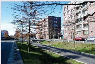
Kombination von Straßenbäumen und Versickerungsmulden am Standort Berlin-Rummelsburg
